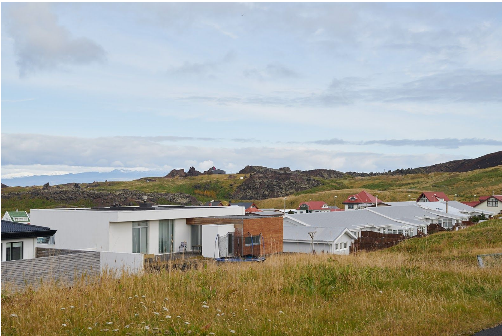
Mynd 3.16: Ásýnd frá göngustíg neðan við Sóleyjargötu 12 sem gefur vísbendingu um hvaða breytingar verða á ásýnd. Stækkun á húsi sést ekki, nýr strompur sést en minna sést í húsið en áður þar sem núverandi aðkoma verður lokað og mön sett þar fyrir.
