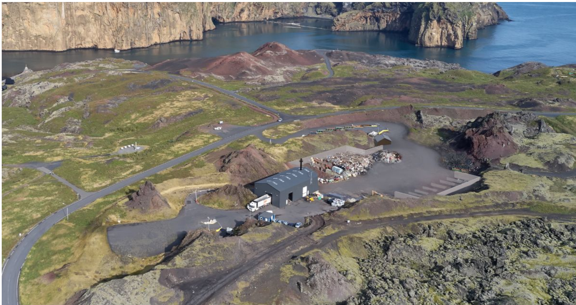
Mynd 3.11: Gróf tölvuunnin mynd af móttöku- og flokkunarstöðinni við Eldfellsveg sem gefur vísbendingu um hvaða breytingar verða á ásjúnd. Búið er að færa aðkomu að svæðinu norðar ásamt flokkunaraðstöðunni fyrir almenning. Aðstaða á vinnusvæðinu bætt með frágengnu yfirboði, steiptum efnishólfum, byggingu sem er aðstaða fyrir starfseminu við flokkunarsvæðið og tekið til á svæðinu næst hraunmyndunum til hægri á myndinni.
