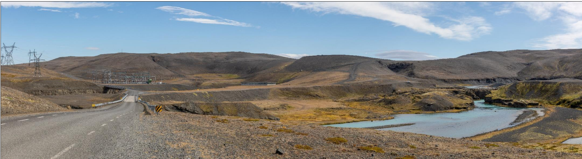
Mynd 2.3 Ljósmynd tekin til norðurs af Fjallabaksleið nyrðri. Sjá má tvær brýr þar sem sú fyrri er yfir gamla farveg Tungnaár, sem í dag gegnir hlutverki yfirfalls. Sú seinni er yfir frárennisskurð Sigöldustöðvar, en fyrir miðri mynd grillir í stöðvarhúsið. Eins og sjá má er svæðið fremur gróðursnautt fyrir utan bakka gamla farvegarins og uppgrædda gróðurbletti í grennd við stöðvarhúsið.
