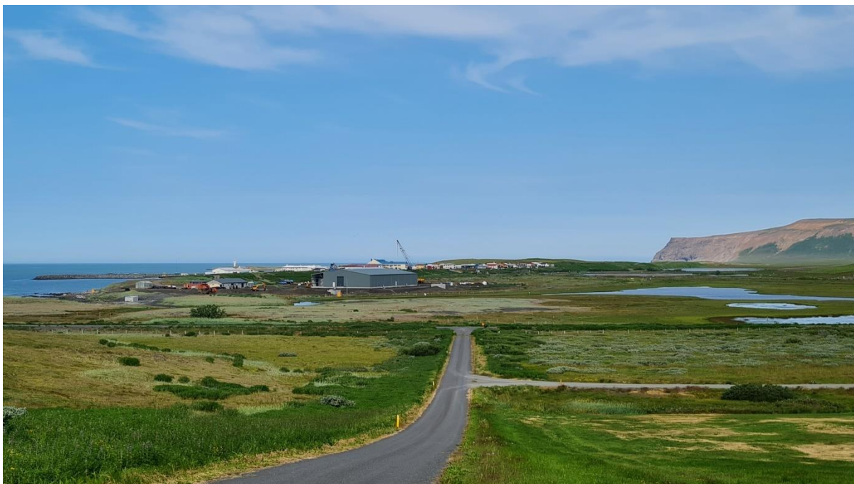
MYND 4.14 Horft í norðurátt að fyrirhuguðu framkvæmdasvæði (fyrir miðju). Sjónlengdir takmarkast við Snartarstaðanúp (til hægri). Hlíðar Snartarstaðanúps eru þaknar ræktuðu skóglendi. Alaskalúpínur vaxa meðfram vegi á miðri mynd. Fyrir miðri mynd má sjá einn kerjapall og þjónustuhús en framkvæmdaraðili hóf laxeldi á pallinum í apríl 2021.
