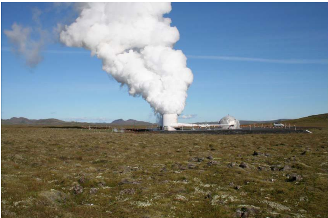
Mynd 4.5 Borhola í blæstri á Hellsisheiði (HE-21). Um er að ræða vinnsluholu en rannsóknarholurnar sem hér er fjallað um verða umfangsminni, bæði borplan og magn gufu við blástur.
