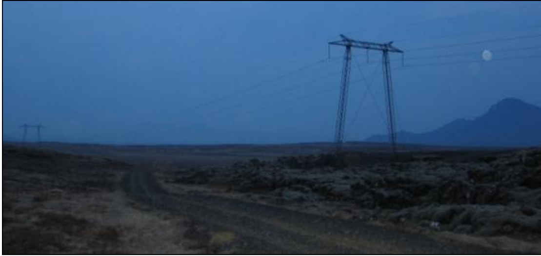
Mynd 3.23 Búrfellslína 3, austan við Selfjall. Horft í átt að Sandskeiði.
