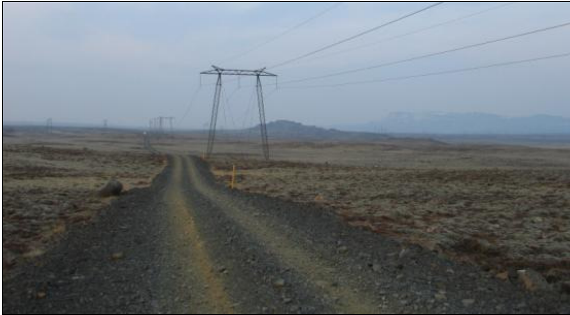
Mynd 3.16 Línuvegurinn meðfram Búrfellslínu 3 á Sandskeiði.
