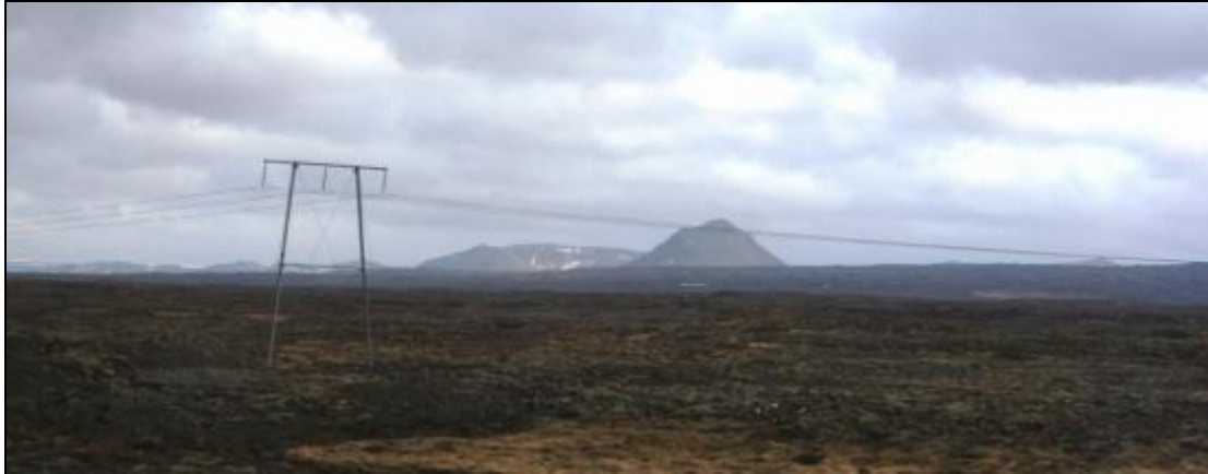
Mynd 3.39 Suðurnesjalína 1, séð frá Reykjanesbraut á mótis við Voga.
