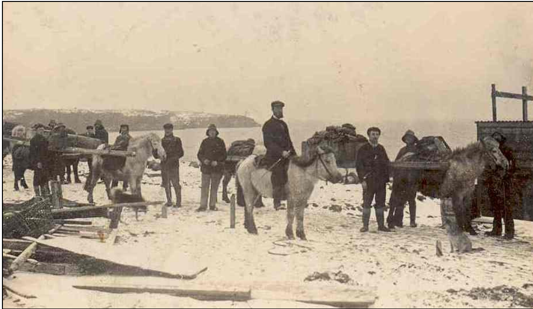
Mynd 3.44 Unnið við byggingu Reykjanesvita árið 1907. Mynd í vörslu Byggðasafns Reykjanesbæjar.
