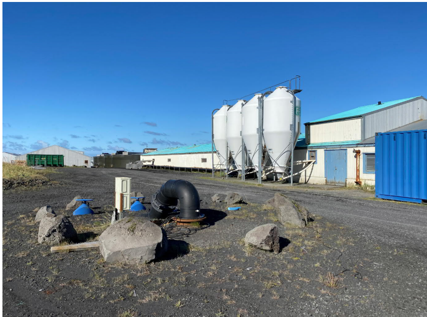
Mynd 2.8 Í forgrunni myndarinnar er ein af mörgum borholum á lóð eldisstöðvarinnar, sem nýtt er til vinnslu grunnvatns. Í náninni framtíð verður byggt hús yfir þessa borholu.
