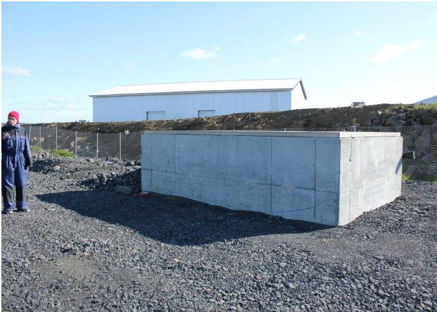
Mynd 2.9 Frárennslispró sem útbúin er með fiskgildru.
